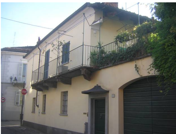
Edifici ordinari riconducibili all'impianto originario
