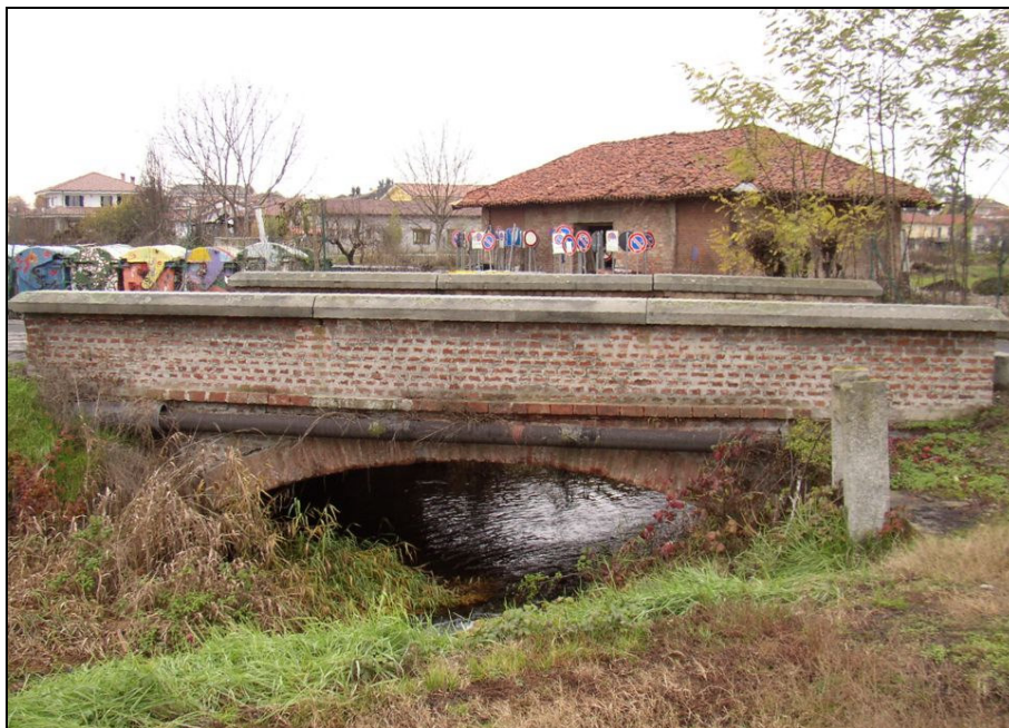
PONTE BARIPO003 (da: BUGNAG016 – foto 016)
