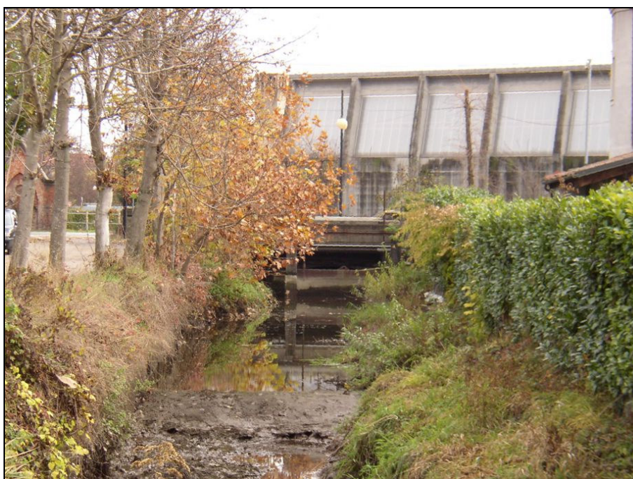
ATTRAVERSAMENTO BARIAG002 (da: BUGNAG014 – foto 011)
