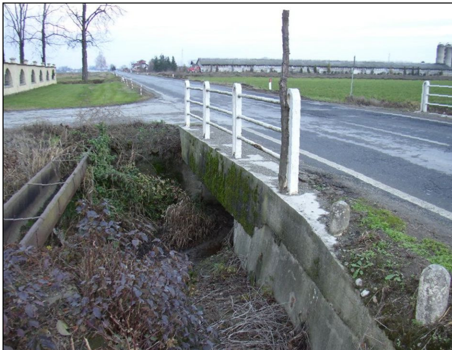
ATTRAVERSAMENTO BARIAG001 (da: BUGNAG001 – foto 032)
