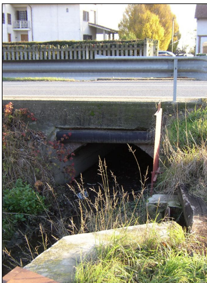
ATTRAVERSAMENTO BARIAG008 (da: BUGNAG009 – foto 027)
