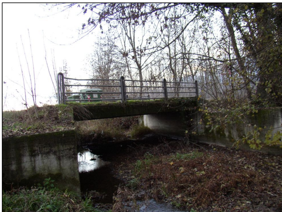
PONTE BARIPO002 (da: BUGNAG002 – foto 031)
