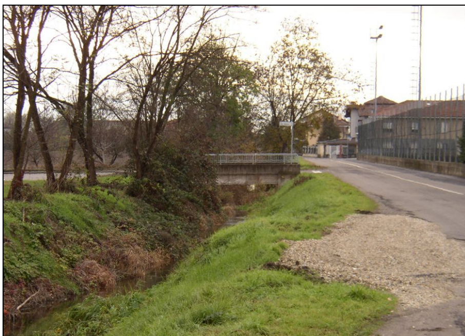
PONTE BARIPO004 (da: BUGNAG017 – foto 017)
